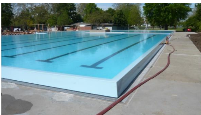
Fotos: Beispiele Folienauskleidung
