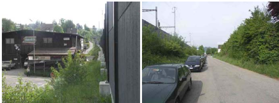
Abbildung 3: Bild links: Blick Richtung Osten, für die geplante Strasse muss das Gewerbegebäude entfernt werden. Bild rechts: Blick Richtung Westen, der bestehende Eiweg dient bereits heute der Erschliessung Eifeld.
